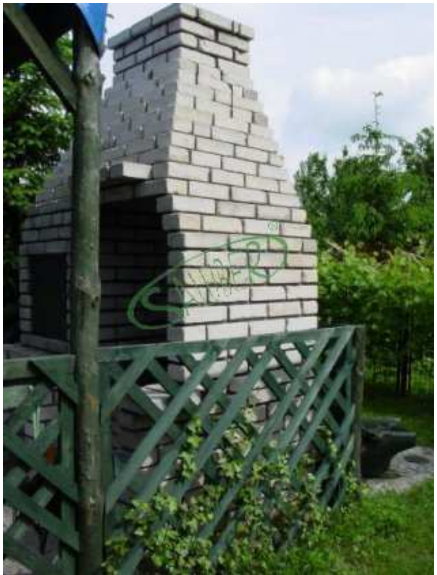
Widok ściany bocznej
