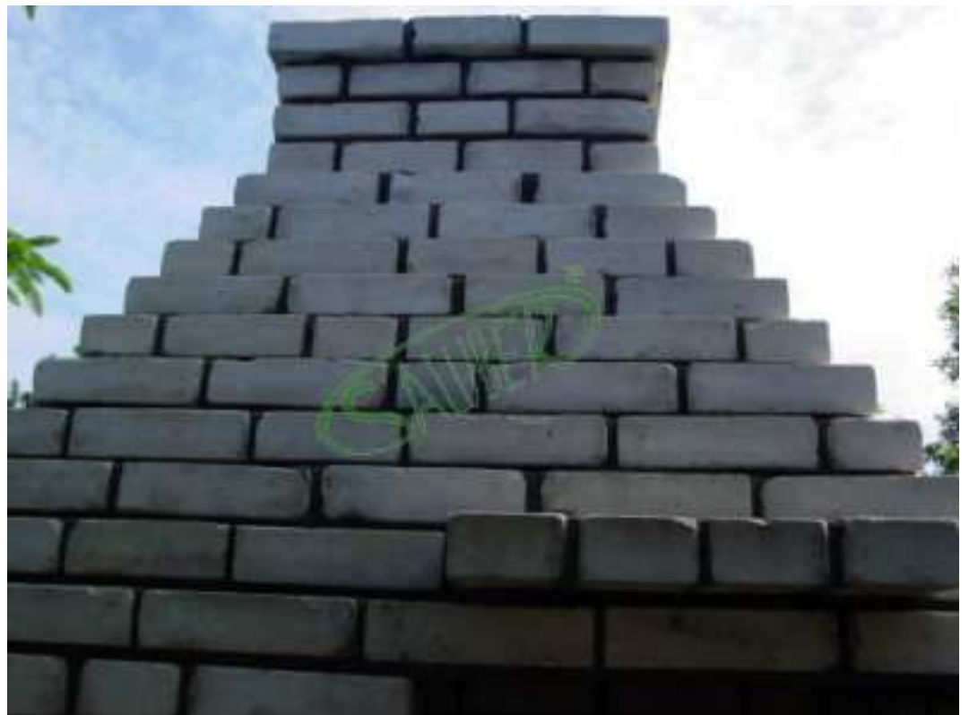
Widok komina z frontu
