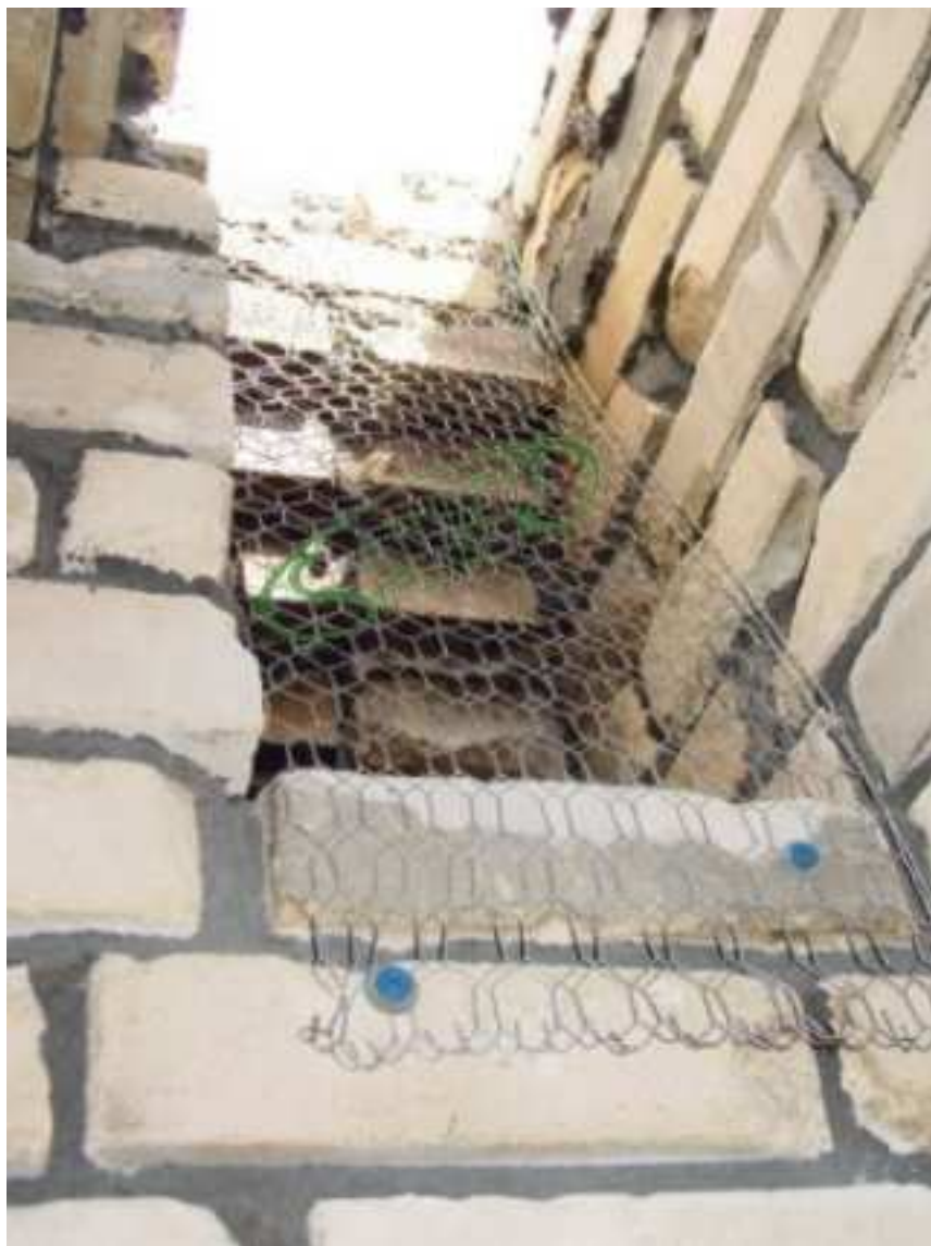
Mocowanie siatki od strony komina grilla
