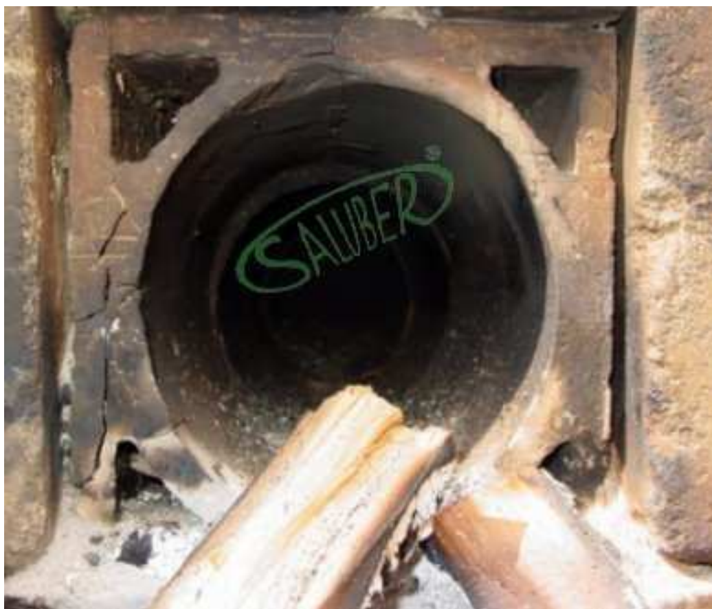
Przewód kominowy paleniska wędzarni
