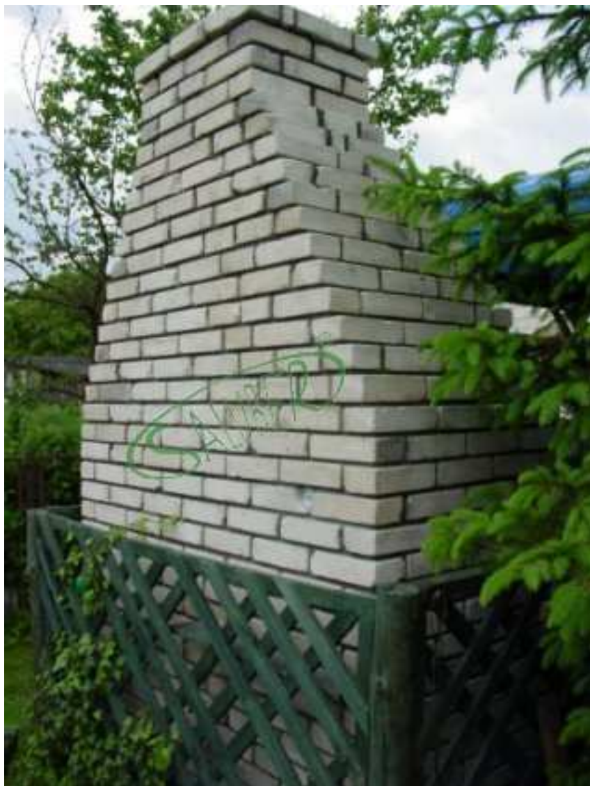
Ściana tylna od strony południowej
