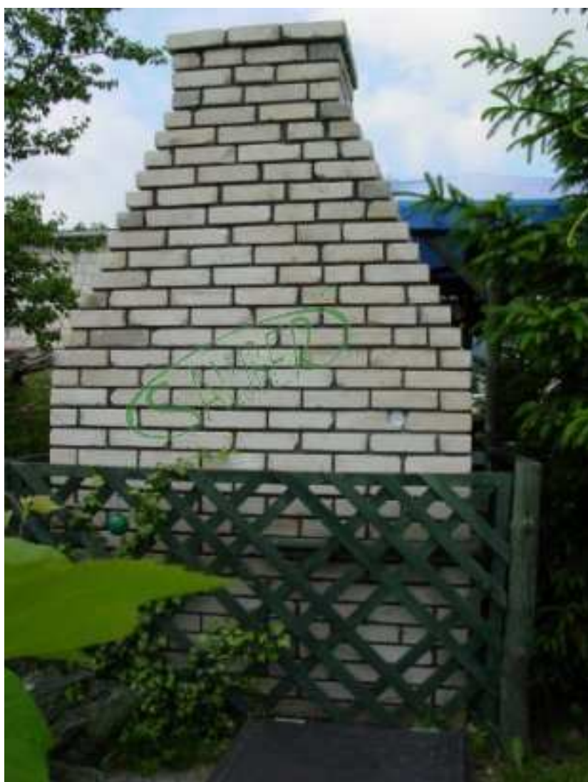
Ściana tylna konstrukcji
